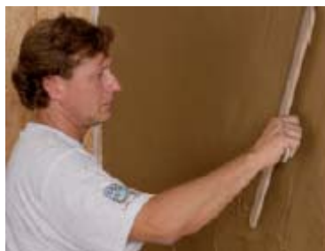
Simítás gumilapos simítóval
