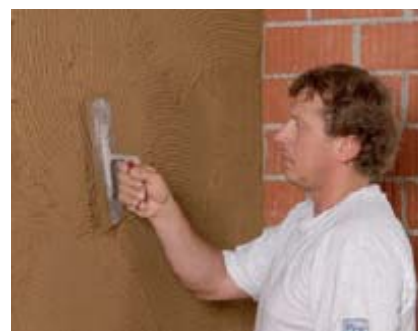
Az alapozó vakolatot fogas glettvassal fésülje fel
