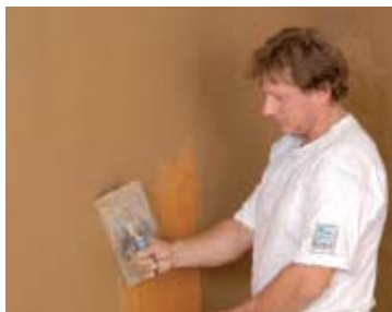
A simítóval nyomja bele a hálót a vakolatba
