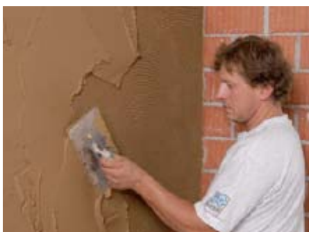
Fedő vályogvakolat felhordása a felfésült alsó vakolatra
