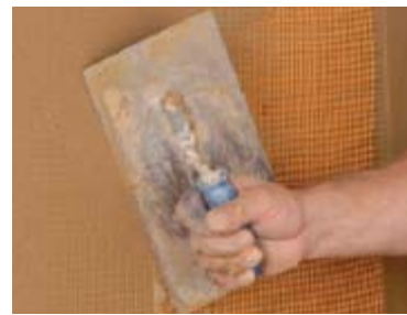
A háló a művelet végén ne legyen látható
