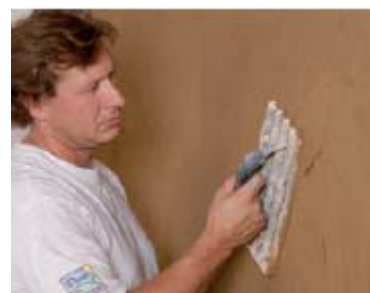
Szükség esetén vakolatgyaluvval dolgozza el az egyenetlenségeket
