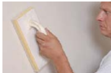
Struktúrállás finom szivacsos simítóval
