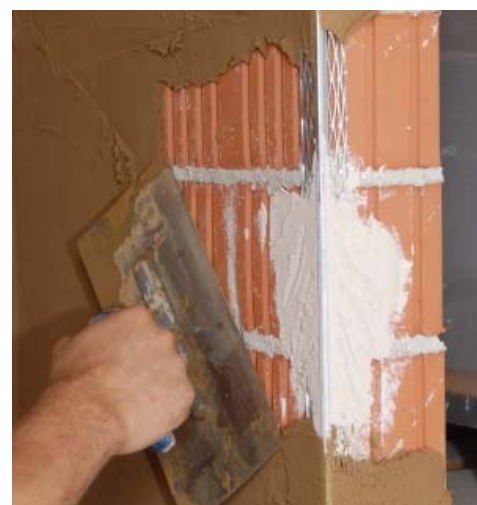
Élvédő sín beépítése
