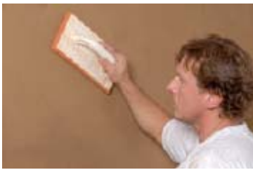
Struktúrállás durva szivacsos simítóval
