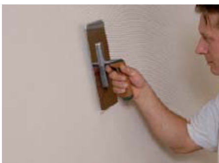
A finom fedő- és nemesvakolatokat 4mm-es fogazású glettvassal fésülje fel
